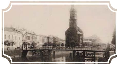
В 1953 году мост реконструировали: деревянное пролётное строение заменили металлическими балками, речные опоры обшили досками.
